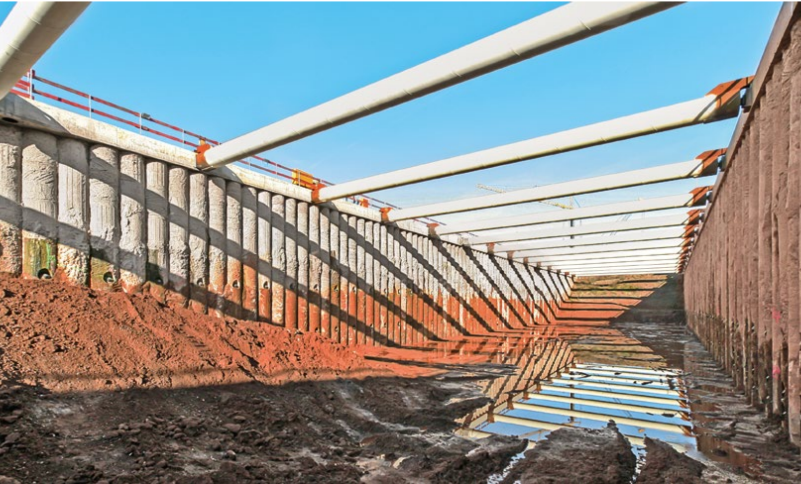
Photos reprinted courtesy of GBS Grundbau Bohrtechnik Spezialtiefbau GmbH & Co. KG, Germany
