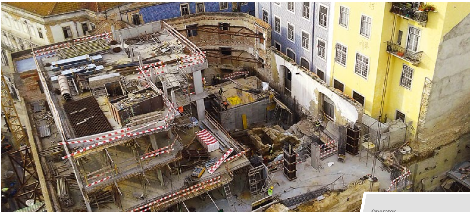
Photos reprinted courtesy of Constructora SANJOSE, S.A. Representação em Portugal, Portugal
