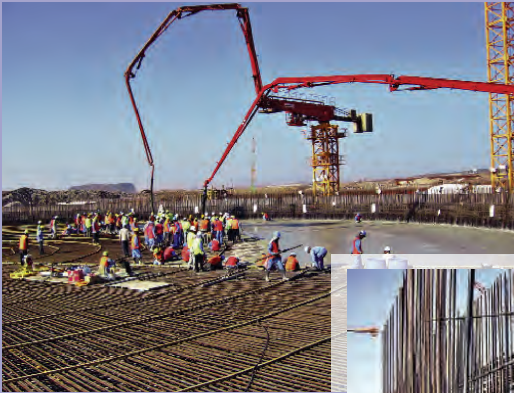
Betonierarbeiten der Bodenplatte
