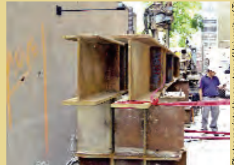
Testing of GEWI® Piles
